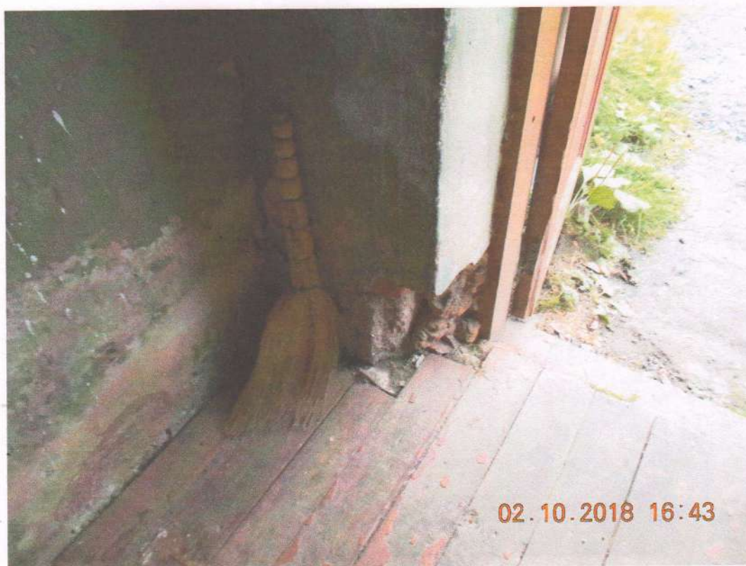
Фото №6. Разрушение фундамента и стен здания.
