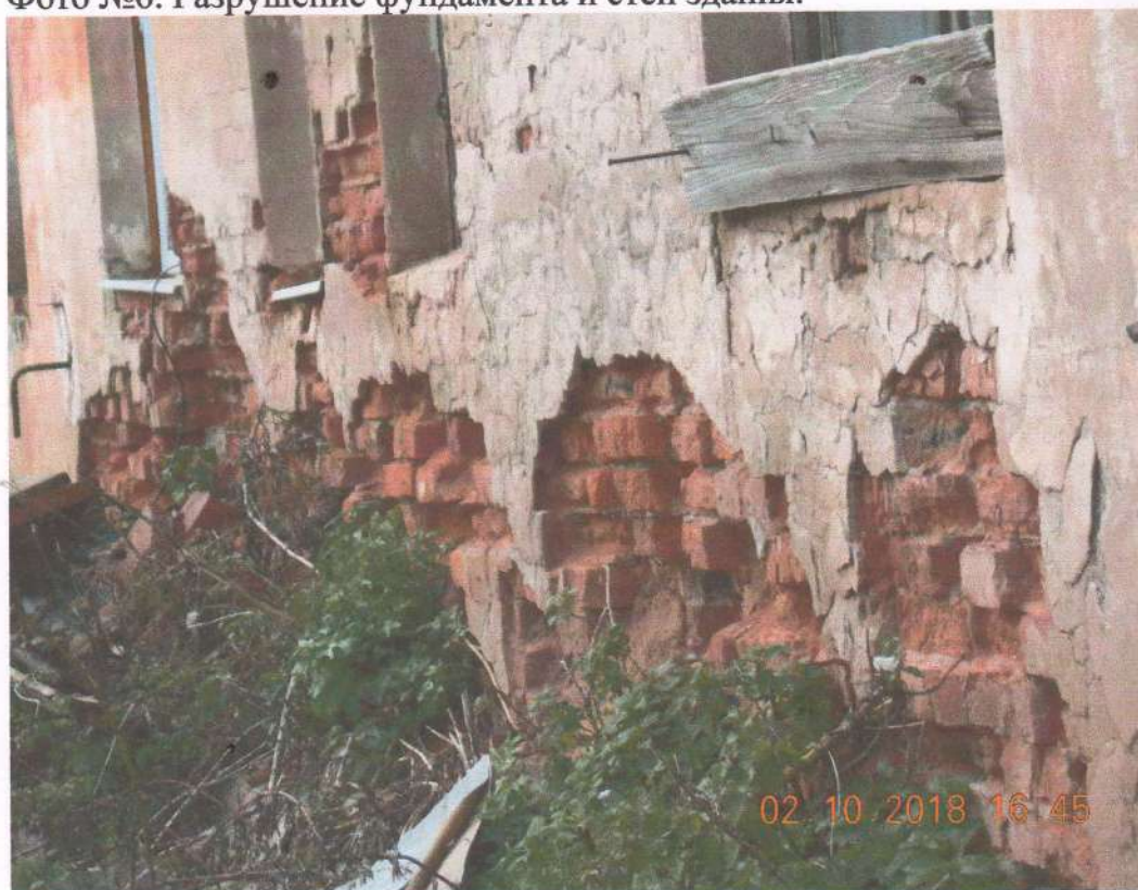
Фото №6. Разрушение фундамента и стен здания.
