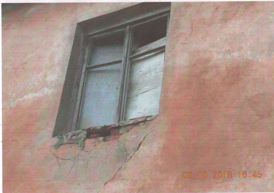
Фото №3. Проемы окон.
