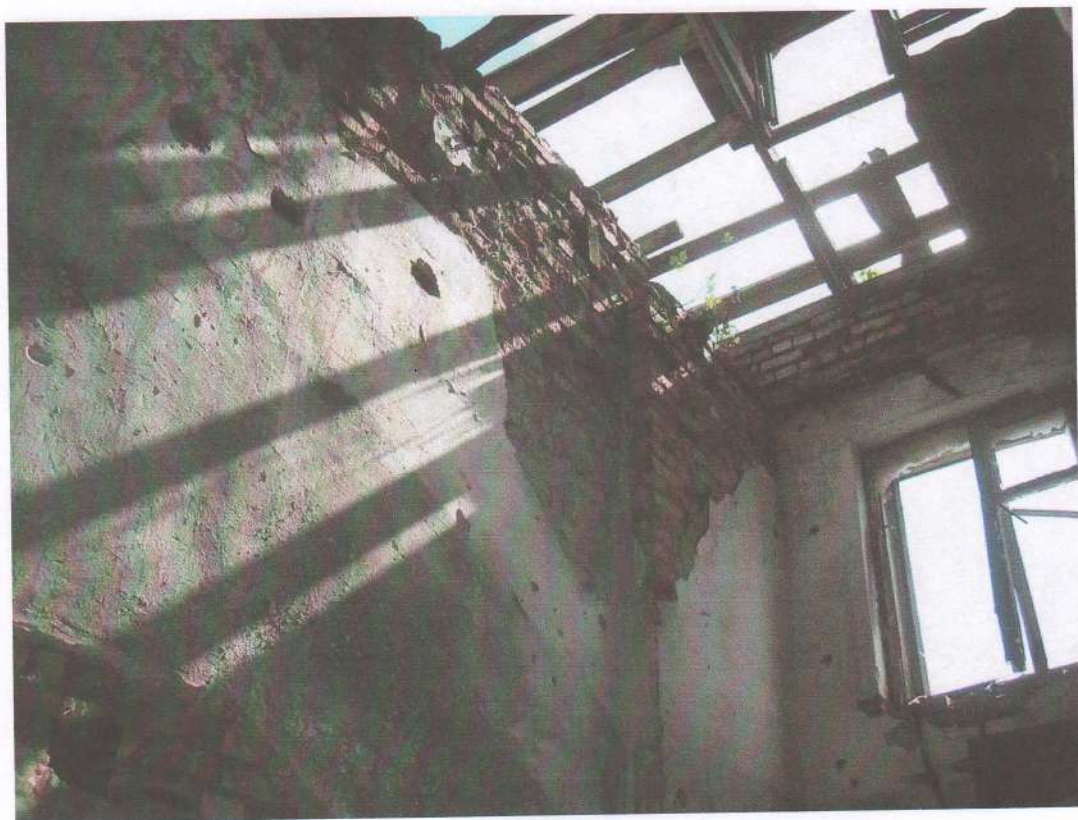
Фото №9. Крыша, потолок.
