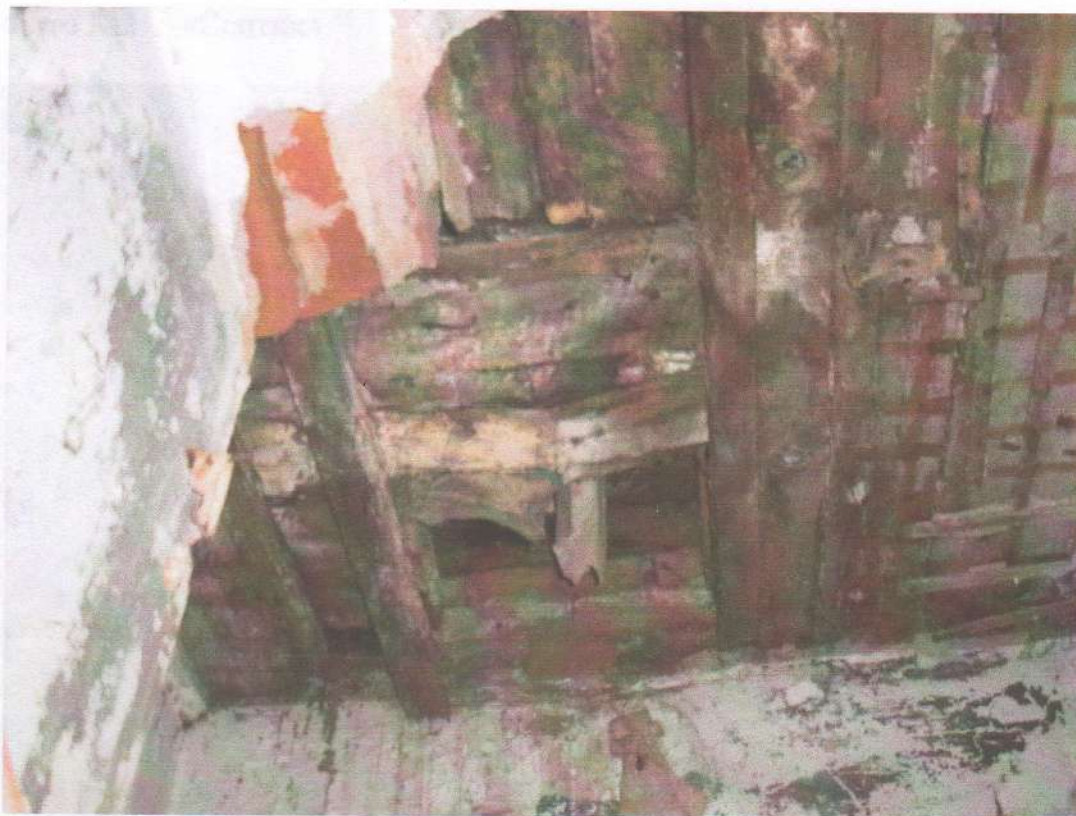
Фото №19. Внутренние стены, обшивка стен.
