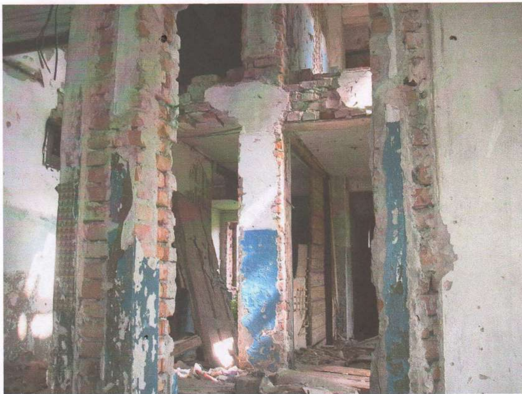
Фото №8. Состояние обшивки внутренних стен.
