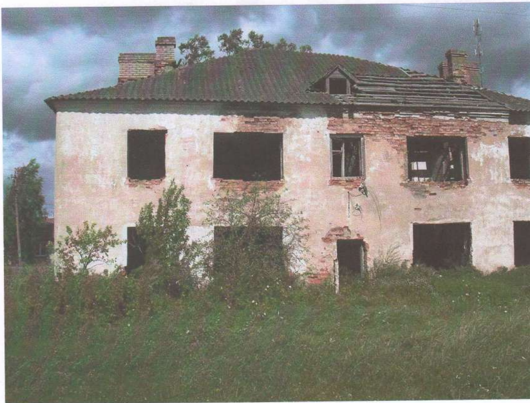
Фото №3. Общий вид. Крыша. Проемы окон.
