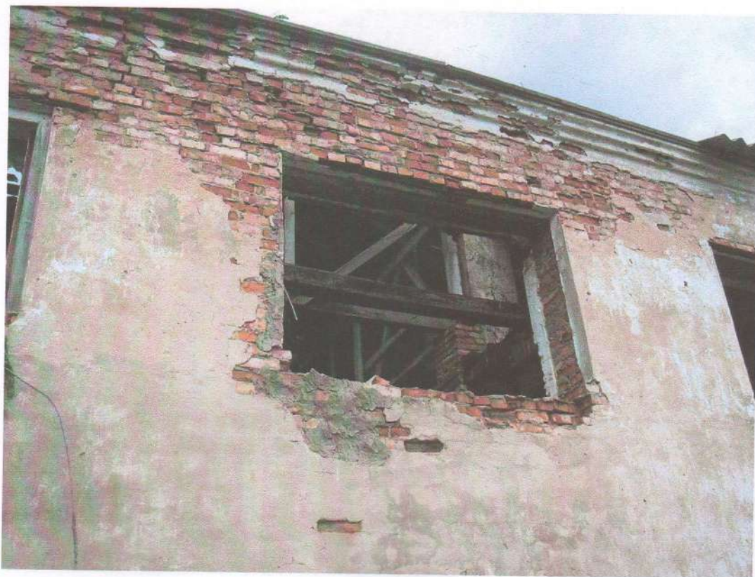
Фото №17. Оконные проёмы, верхняя часть фасада слева.
