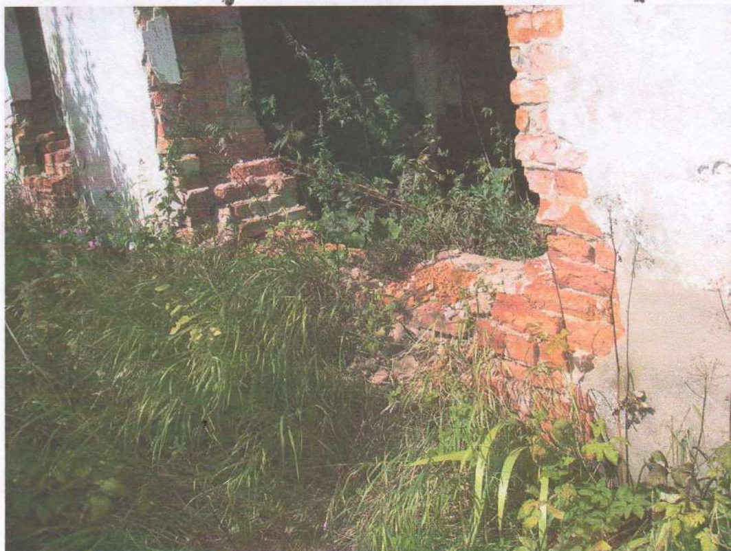
Фото №6. Проемы окон.
