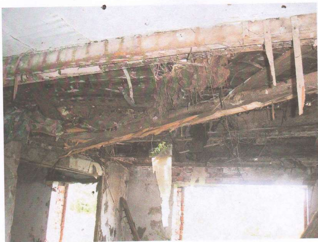
Фото №10. Перекрытия на второй этаж.
