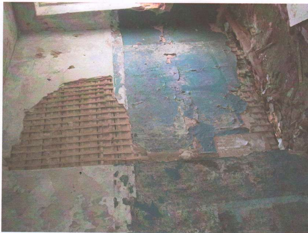
Фото №20. Внутренние стены, обшивка стен
